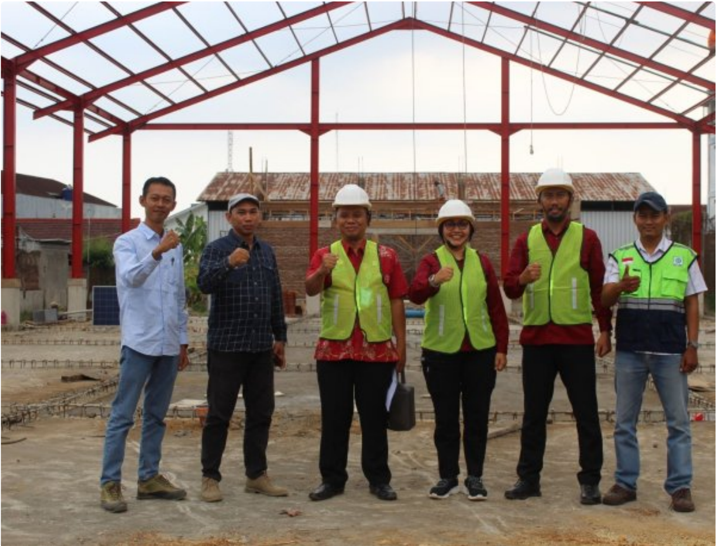
UKPBJ Setwil Jateng Tinjau Progres Pembangunan Gudang Basan Baran Rupbasan Purwokerto
